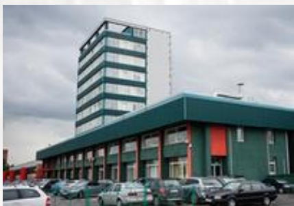
Пивоварня Хейнекен Санкт-Петербург
